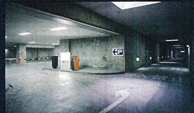
地下2階駐車場
