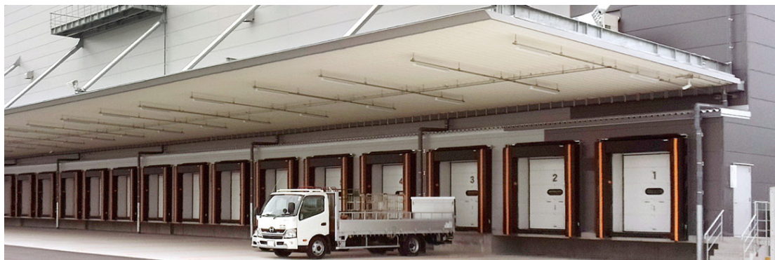
工場・物流倉庫
