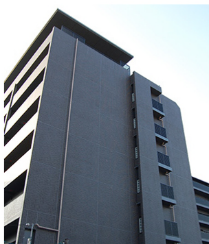
プラネスーペリア奈良三条通り
